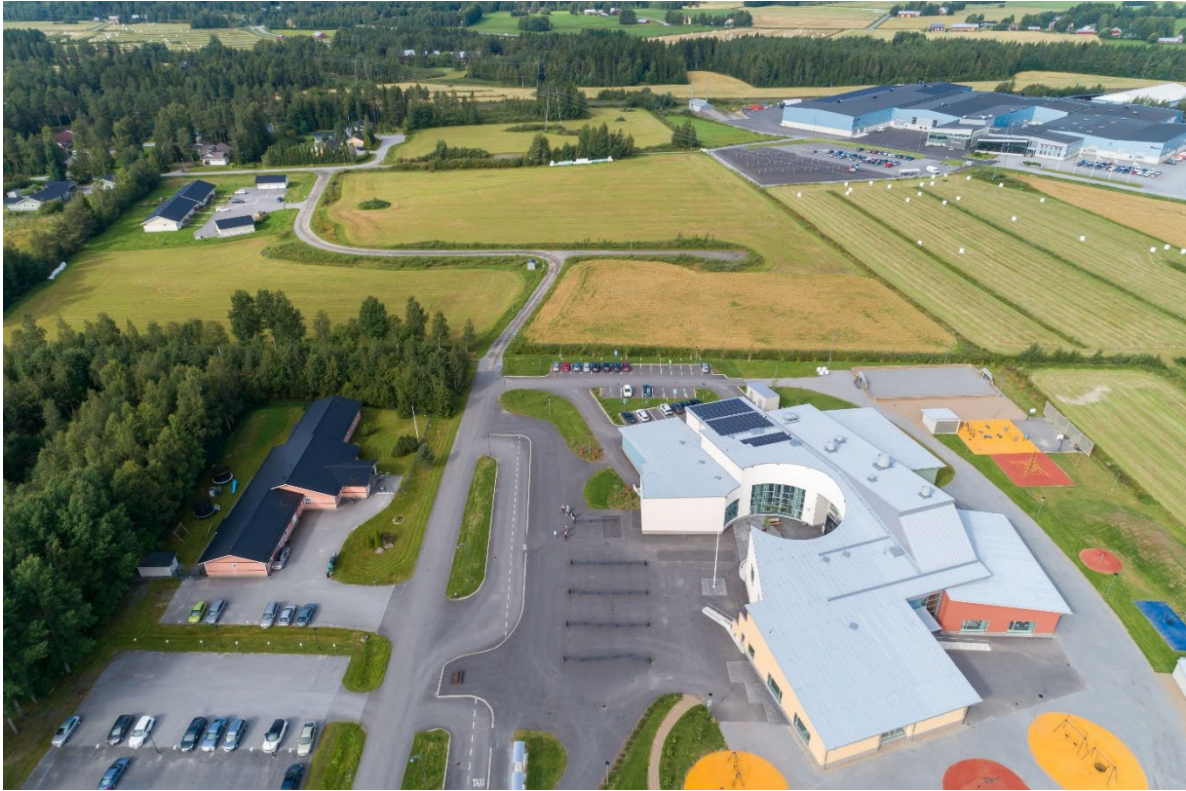
Kuva 4. Ilmakuva suunnittelualueesta kaakosta päin. Axåkers skola kuvan oikeassa kulmassa.
