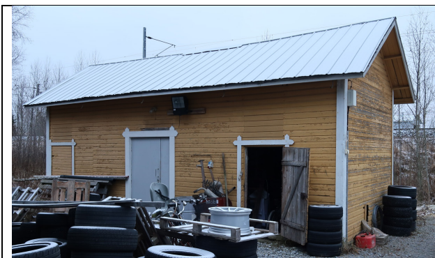
Äldre gårdsbyggnad invid tågrälsen.
