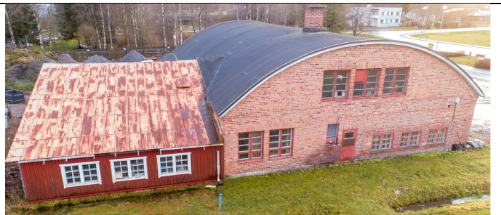
Fasad från öst. I målfärgen på fasaden av den träbeklädda delen syns den del som revs på 1990-2000-talet.
