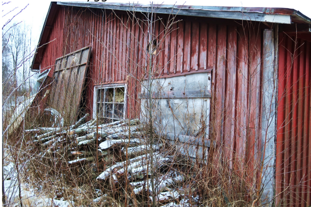
Fasaden på trädelen av byggnaden mot öst.
