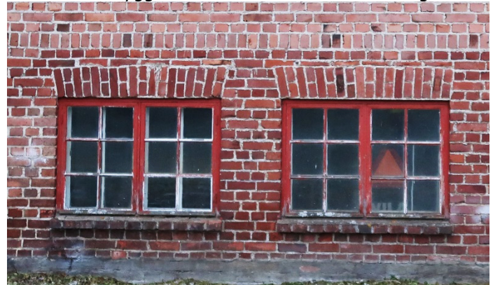
Första våningens fönster i norra gaveln.
