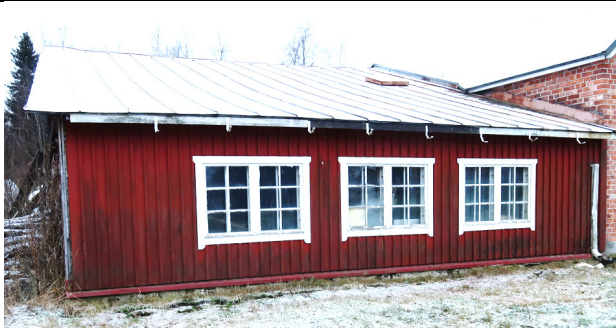
Trädelen av byggnaden från norr.
