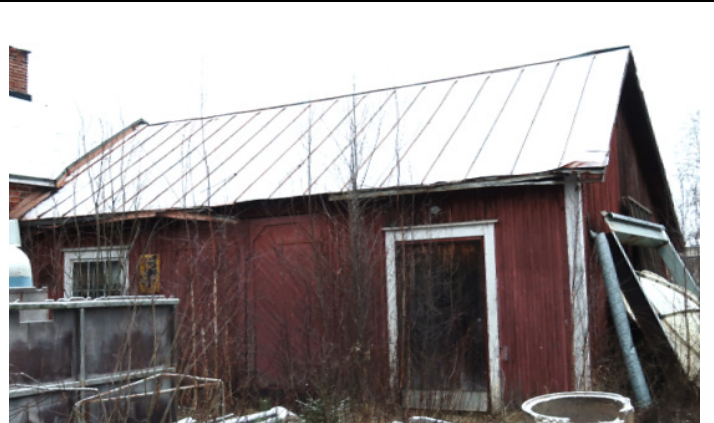
Trädelen av byggnaden från söder.
