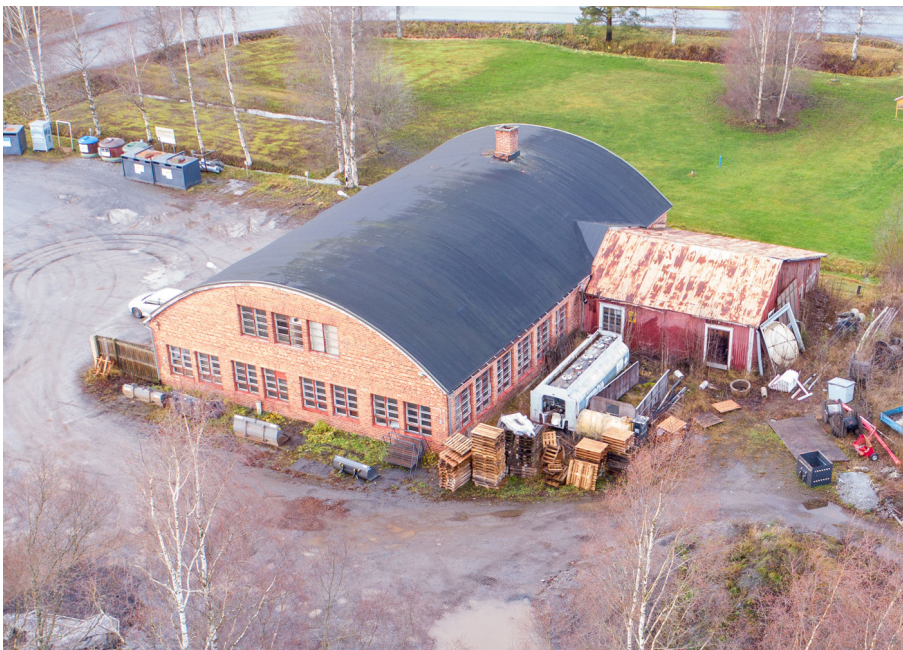
Bild 5. Befintlig skyddad verkstadsbyggnad. Byggnaden är skyddad enligt miljöministeriets beslut från 2008. Bild: Pedersöre kommun.
