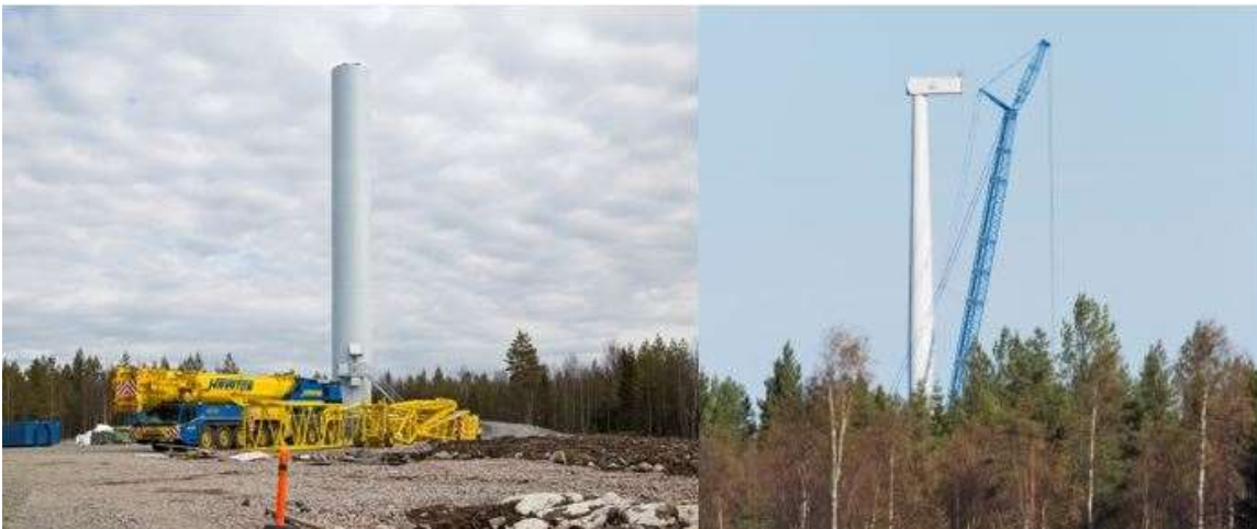
Kuva 85. Tuulivoimalan kokoamista (Ville Suorsa, FCG).
