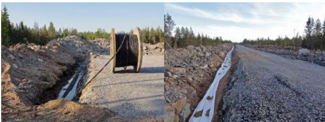
Kuva 83. Maakaapelit upotetaan huoltoteiden yhteyteen (Ville Suorsa, FCG).
