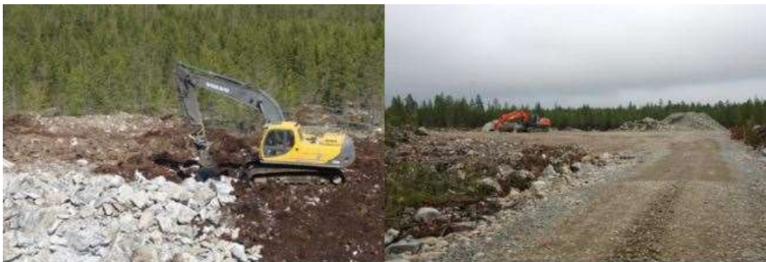
Kuva 82. Tuulivoimapuiston rakentaminen alkaa huoltoteiden ja pystytysalueiden rakentamisella (Ville Suorsa, FCG).
