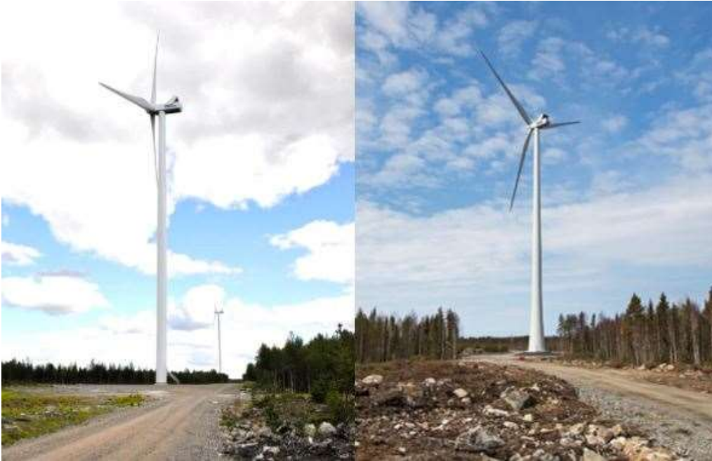
Kuva 75. Vasemmalla on esimerkki teräslieriötornista ja oikealla hybriditornista (Leila Väyrynen ja Ville Suorsa, FCG).
