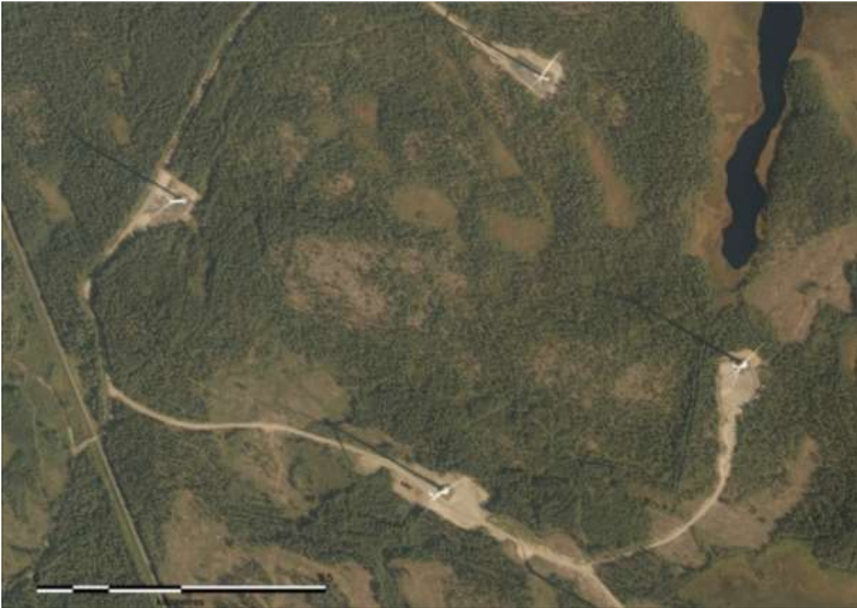
Kuva 74. Esimerkkikuva toiminnassa olevasta tuulivoimapuistosta. Tuulivoimaloita varten on rakennettu huoltotiet ja nostokentät. Tuulivoimaloiden ympäristössä ja välialueilla aikaisempi maankäyttö on säilynyt ennallaan.
