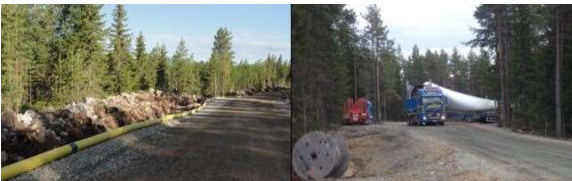
Kuva 81. Vasemmalla esimerkki tuulivoimapuiston rakennus- ja huoltotiestä. Teitä käytetään muun muassa betonin, soran ja voimaloiden komponenttien kuljetuksiin sekä tuulivoimapuiston käyttövaiheessa huoltoajoihin. Maakaapeli sijoitetaan ojakaivantoon tien reuna-alueelle. Oikealla tuulivoimalan osia kuljetetaan erikoiskuljetuksina. (Ville Suorsa, FCG)
