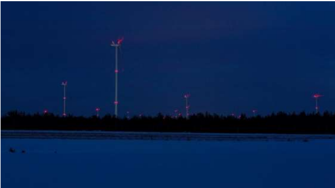
Kuva 77. Kiinteät punaiset lentoestevalot (Ville Suorsa, FCG).
