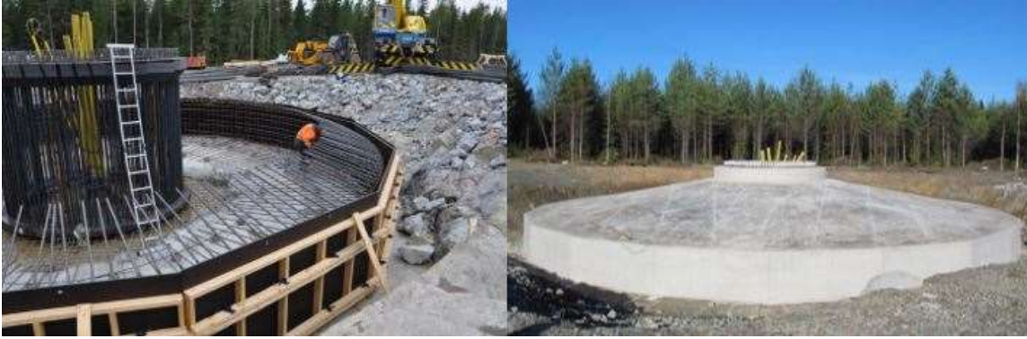
Kuva 84. Tuulivoimalan perustusten rakentamista (Leila Väyrynen, FCG).
