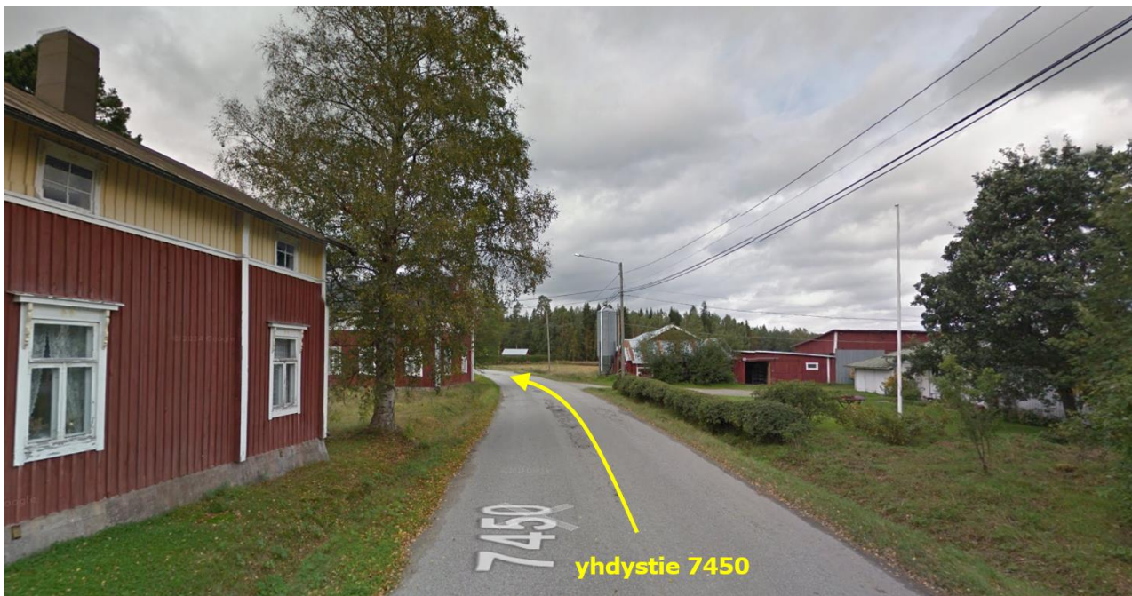
Kuva 8: Yhdystien 7450 länsipäässä on rakennuksia lähellä tietä (Google Maps 2024).
