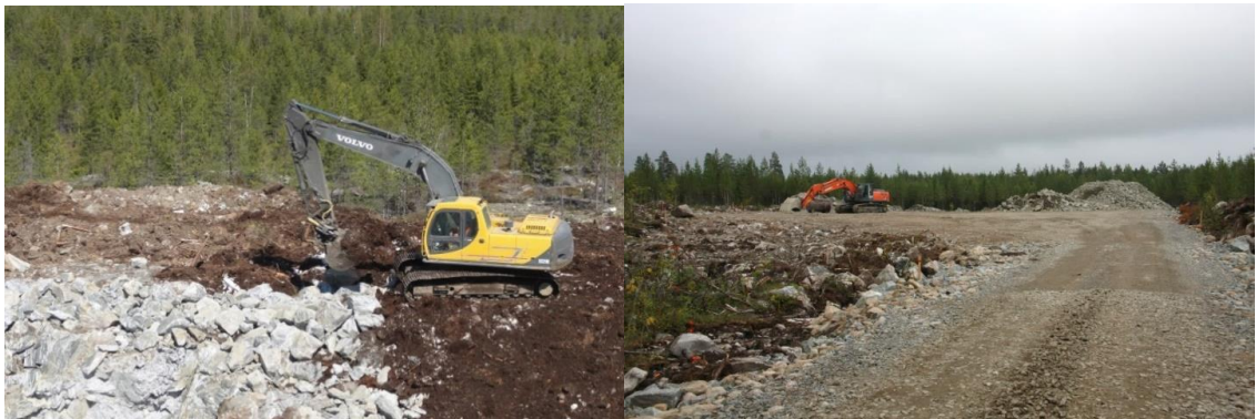
Kuvapari 5.9. Tuulivoimapuiston rakentaminen alkaa huoltoteiden ja pystytysalueiden rakentamisella. (Kuvat: Ville Suorsa / FCG)
