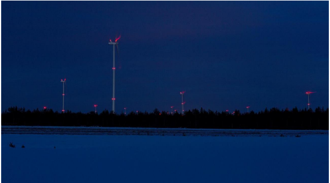
Kuva 5.4. Kiinteät punaiset lentoestevalot. (Kuva: Ville Suorsa / FCG)
