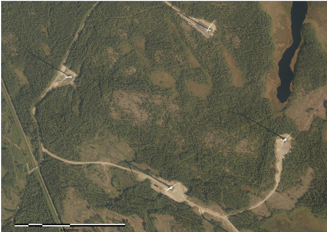
Kuva 5.1. Esimerkki-ilmakuvassa näkyy toiminnassa olevia tuulivoimaloita. Tuulivoimaloita varten on rakennettu huoltotiet ja nostokentät. Tuulivoimaloiden ympäristössä ja välialueilla aikaisempi maankäyttö on säilynyt ennallaan.
