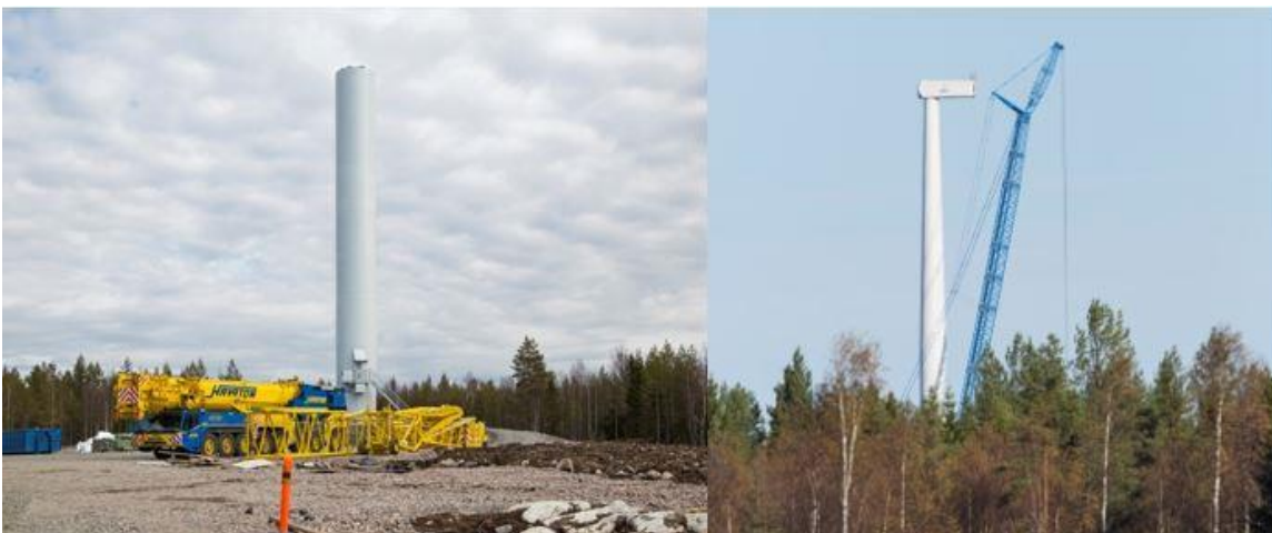
Kuva 90. Tuulivoimalan kokoamista (Ville Suorsa, FCG).
