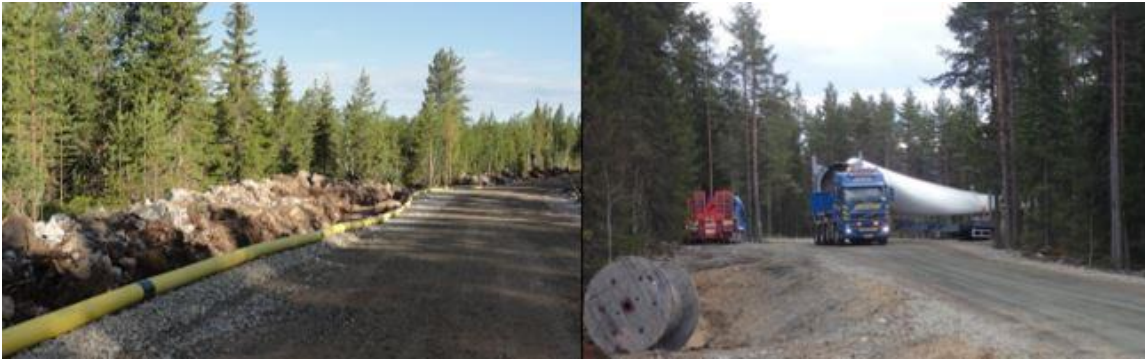
Kuva 86. Vasemmalla esimerkki tuulivoimapuiston rakennus- ja huoltotiestä. Teitä käytetään muun muassa betonin, soran ja voimaloiden komponenttien kuljetuksiin sekä tuulivoimapuiston käyttövaiheessa huoltoajoihin. Maakaapeli sijoitetaan ojakaivantoon tien reuna-alueelle. Oikealla tuulivoimalan osia kuljetetaan erikoiskuljetuksina. (Ville Suorsa, FCG)
