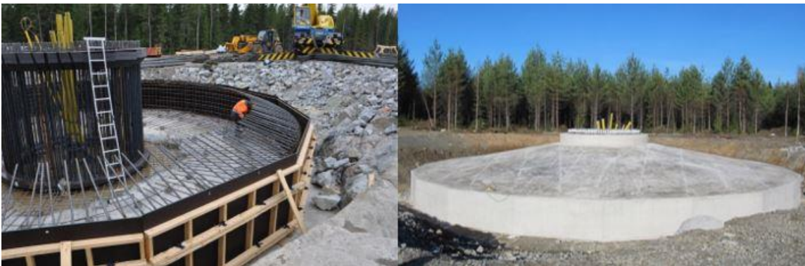
Kuva 89. Tuulivoimalan perustusten rakentamista (Leila Väyrynen, FCG).
