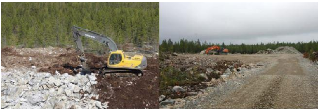
Kuva 87. Tuulivoimapuiston rakentaminen alkaa huoltoteiden ja pystytysalueiden rakentamisella (Ville Suorsa, FCG).
