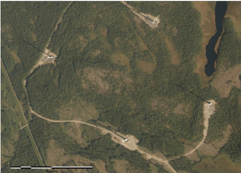
Kuva 79. Esimerkkikuva toiminnassa olevasta tuulivoimapuistosta. Tuulivoimaloita varten on rakennettu huoltotiet ja nostokentät. Tuulivoimaloiden ympäristössä ja välialueilla aikaisempi maankäyttö on säilynyt ennallaan.
