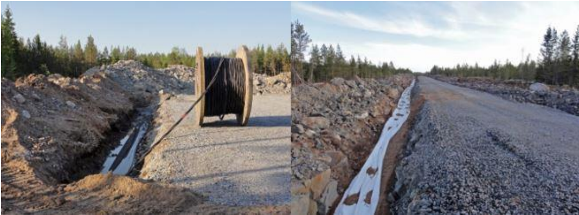
Kuva 88. Maakaapelit upotetaan huoltoteiden yhteyteen (Ville Suorsa, FCG).
