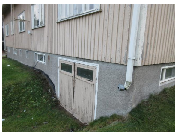
Ingång till garaget i källaren
