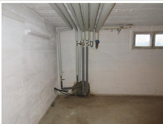
Platsgjutna betongväggar i källare
