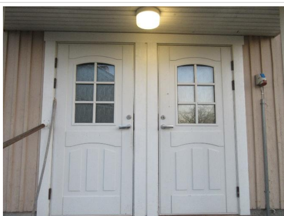
Ytterdörr vid huvudingång i bra skick
