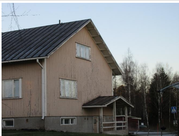
Byggnadens östra sida, ingång till omklädningsrum
