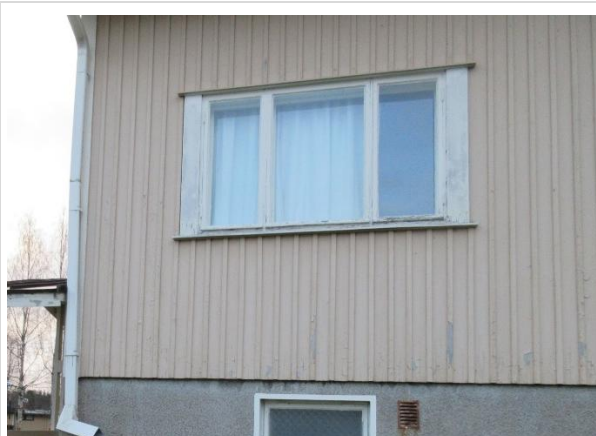
Fönster från utsida
