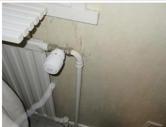
Spricka på vägg under fönster
