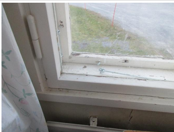
Fönster från insida
