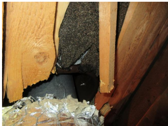
Genomföring som har åtgärdats
