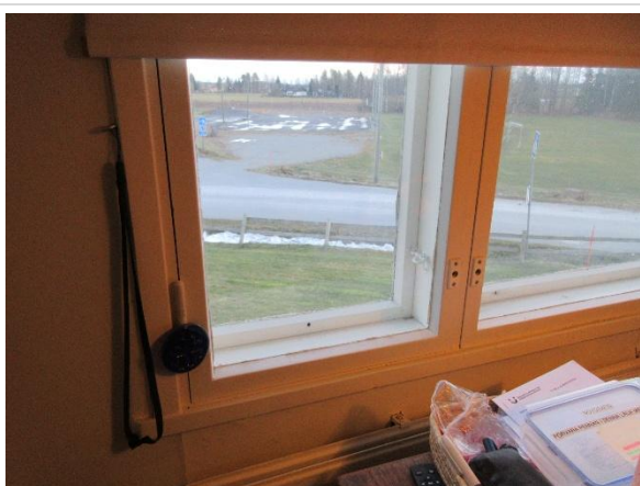
Fönster från insida
