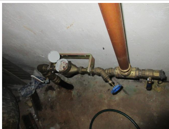
Inkommande vattenledning förnyad
