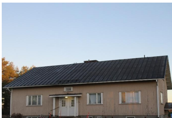
Vattentaket fotat från framsidan
