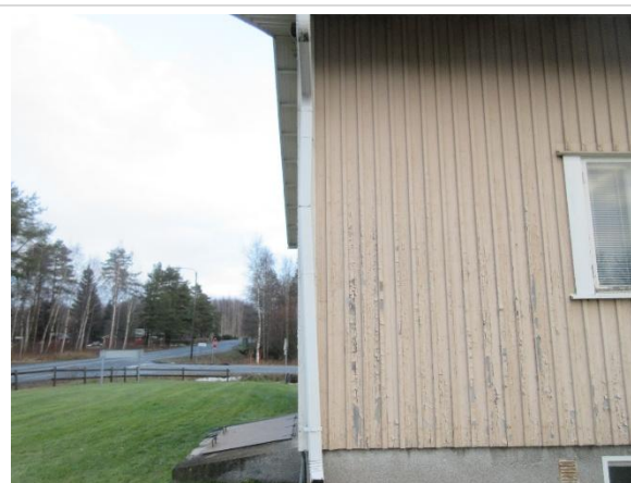
Byggnadens västra sida
