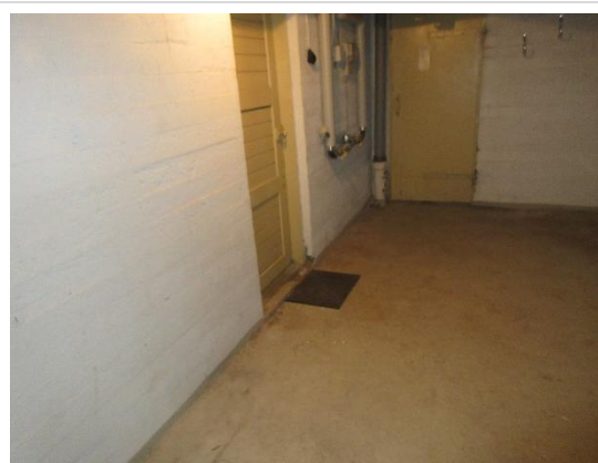
Platsgjutna betongväggar i källare
