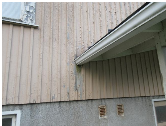
Hängränna direkt mot fasadpanel
