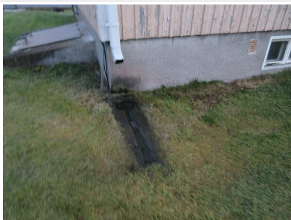
Betongränna under utkastare
