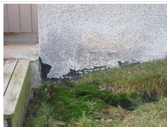
Bitumen strykning på sockeln
