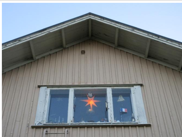
Fönster på gavel våning 2
