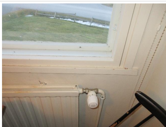
Fönster från insida, dubbla enkel glas
