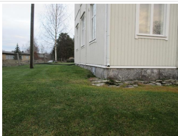
Byggnadens västra sida mot vägen
