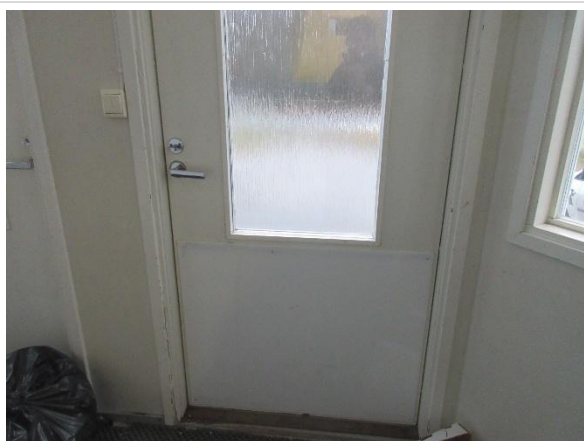
Ytterdörr från insidan
