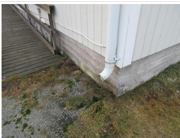
Regnvatten leds ut på marken framför ramp
