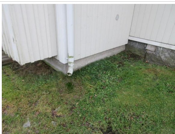
Regnvatten leds direkt ner på gräsmattan
