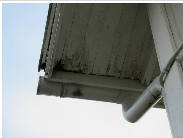
Murket takutskift vid köksingång
