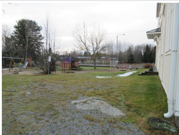
Betongränna under utkastare
