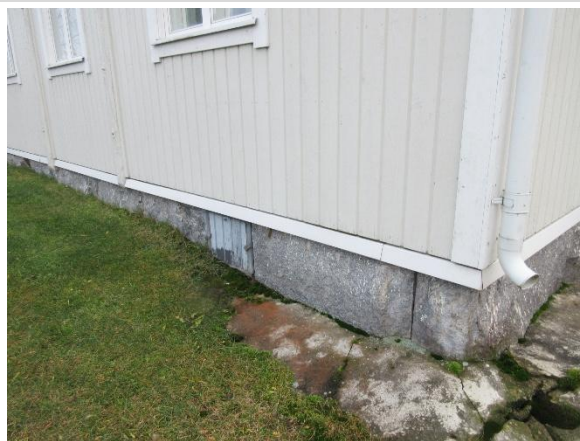
Lucka till krypgrund i sydvästra hörnet
