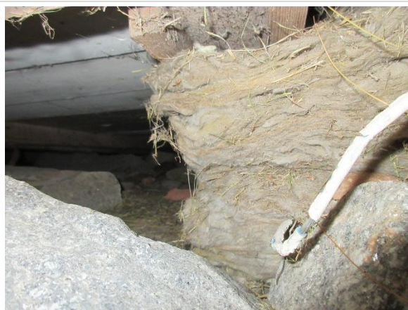
Synlig isolering i krypgrundsutrymmet
