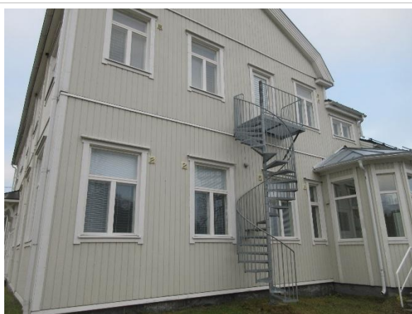
Fasad med utrymningsväg
