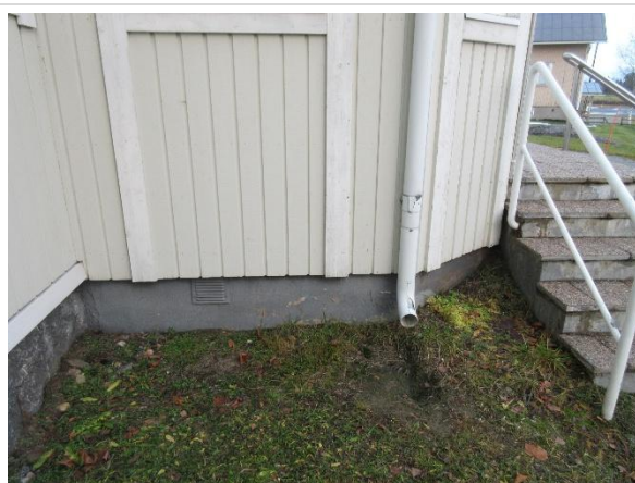
Regnvatten leds på marken
