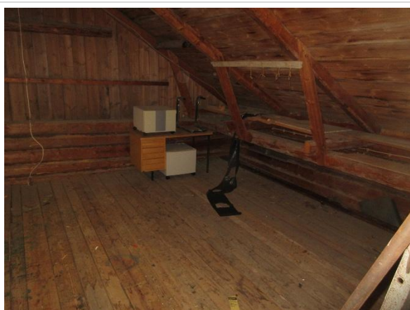
Kallvind ovanför matsal och klassrum
