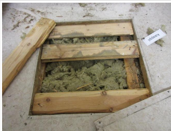
Kontrollucka i golv våning 1
